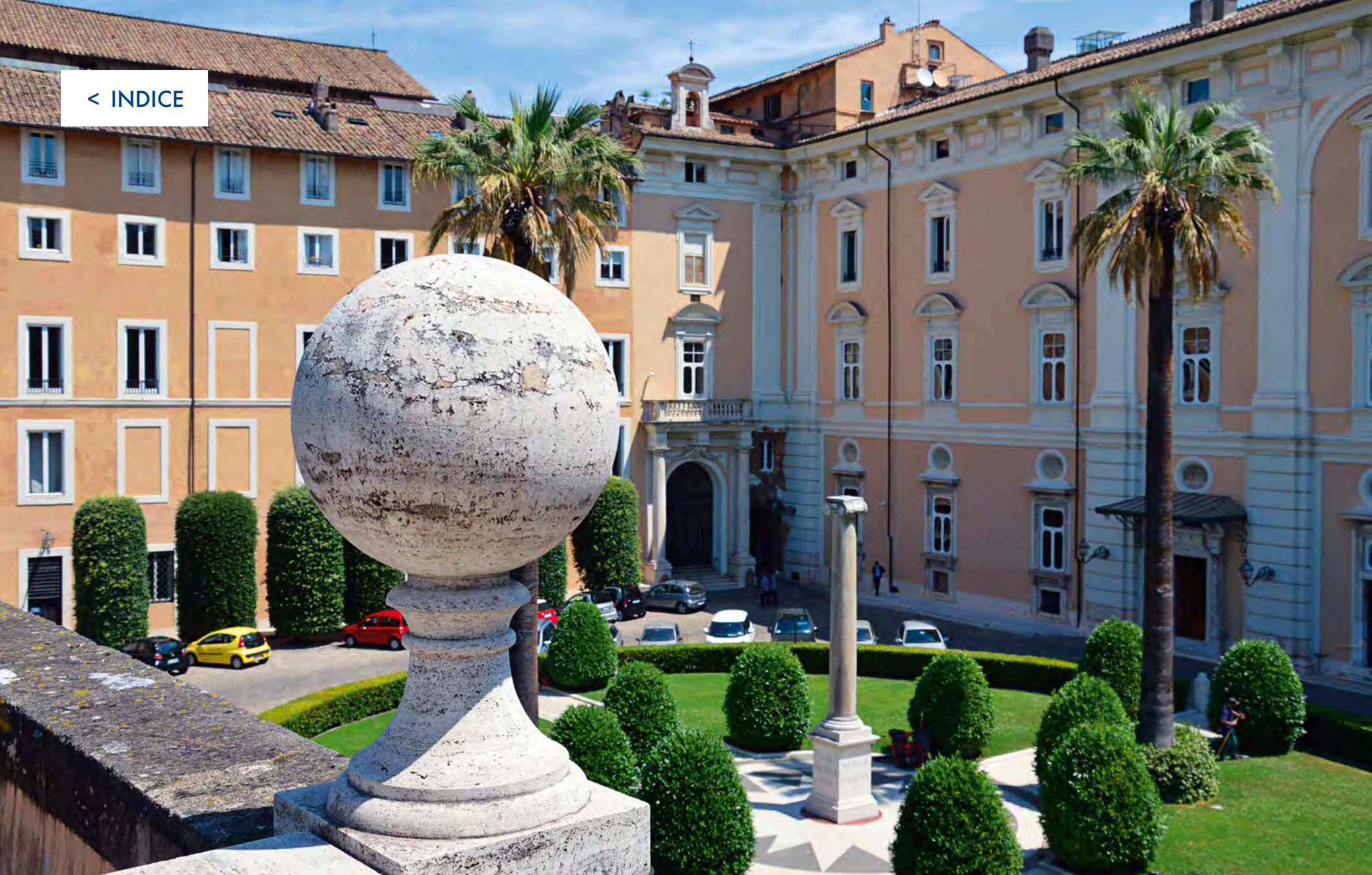
Sede di Confindustria Radio Televisioni, Palazzo Colonna, Roma
